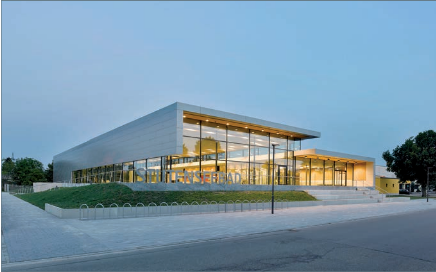
■ Ansicht von Nordwesten mit den Fahrradstellplätzen
