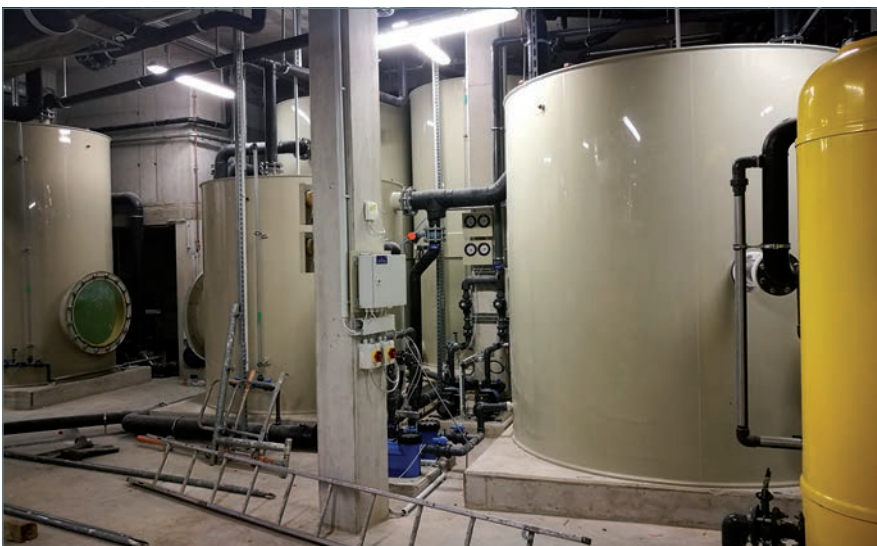
■ ... sowie Aktivkohlefilter und Rohwasserspeicher für das Planschbecken, Fotos: 4a Architekten GmbH, Stuttgart
