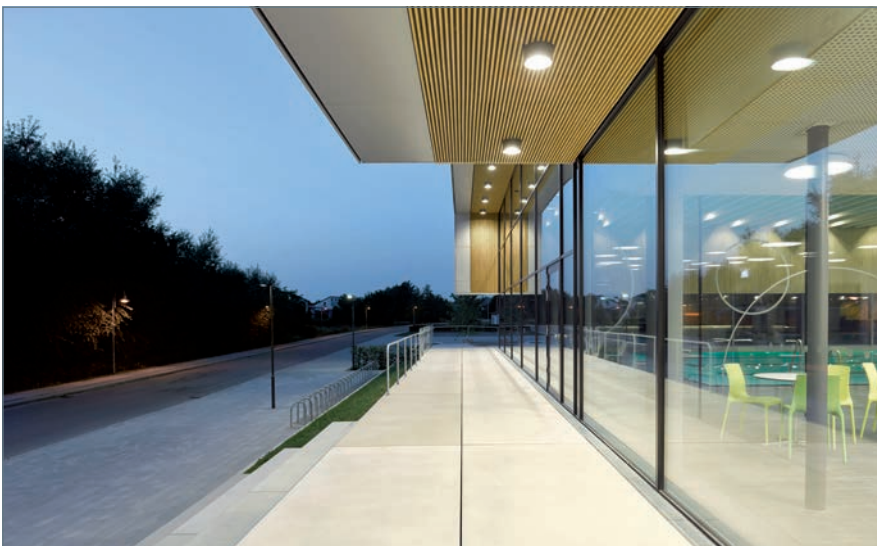
■ Das Eingangspodest mit Blick in das Foyer, ...
