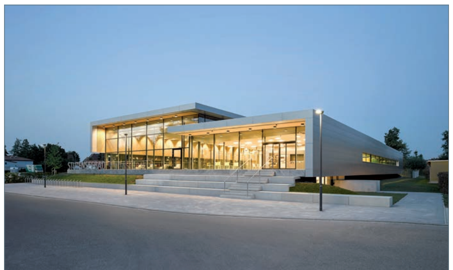
■ Ansicht von Westen mit der Eingangsseite
